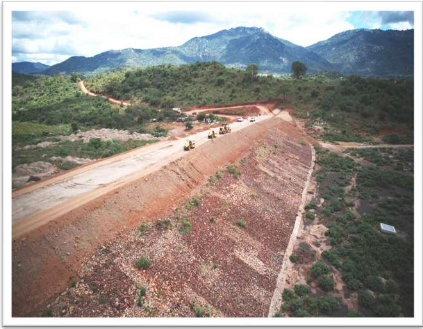
Picha Na.7: Ujenzi wa tuta la bwawa katika Mradi wa Umwagiliaji - Membe Dodoma
