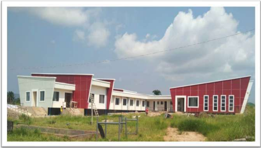
Picha Na. 2: Ujenzi wa ofisi za Kituo cha TARI Kihinga mkoani Kigoma
